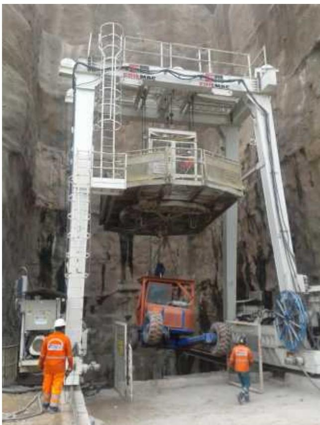
Centrale idroelettrica di Cambambe' in Angola. Calata di un escavatore nel pozzo mediante carroponte
