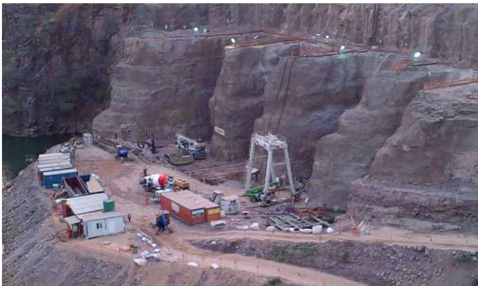
Centrale idroelettrica di Cambambe' in Angola. Cantiere per scavo e allargamento pozzi
